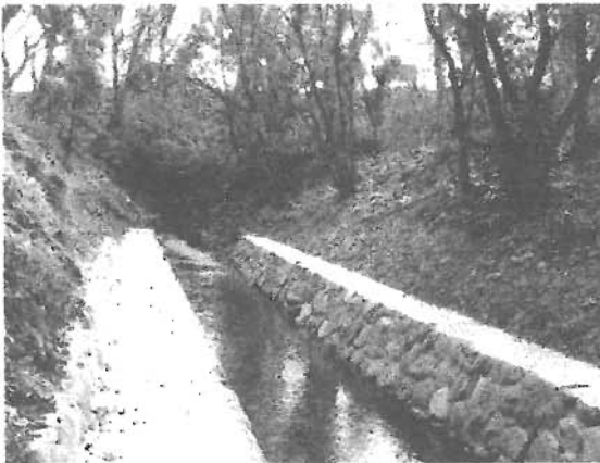
護岸工事をした三ヶ村泉
