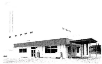
川内町清掃センター
