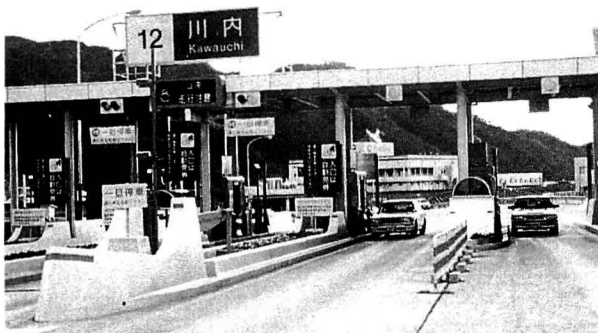
完成したインターチェンジ (上 高松へ 下 松山へ)
