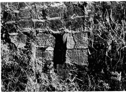
三軒屋焼窯跡（松瀬川三軒屋にあり）
