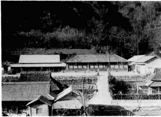
土谷小学校全景 (右端は講堂)
