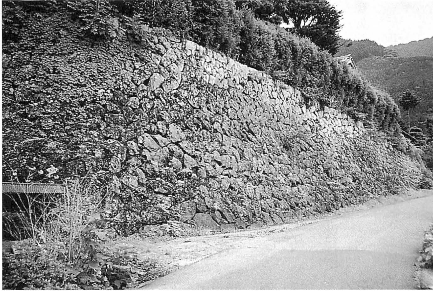
K氏の石垣（手前林道。根石は林道面より約2米下にあり）（2007年7月）
