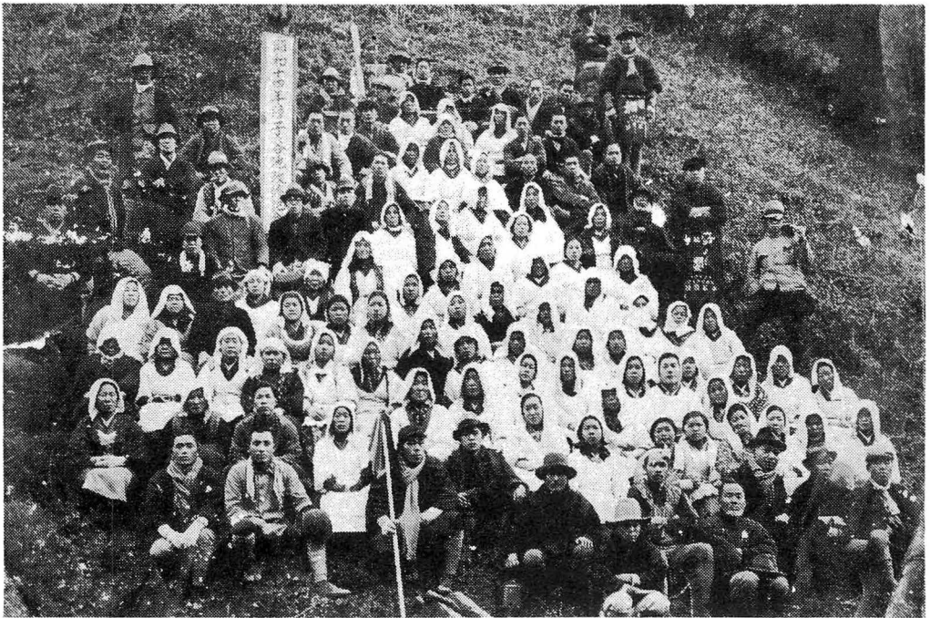
障子ヶ谷の池普請 昭和14年
